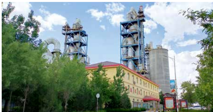
太阳山分厂中控楼
