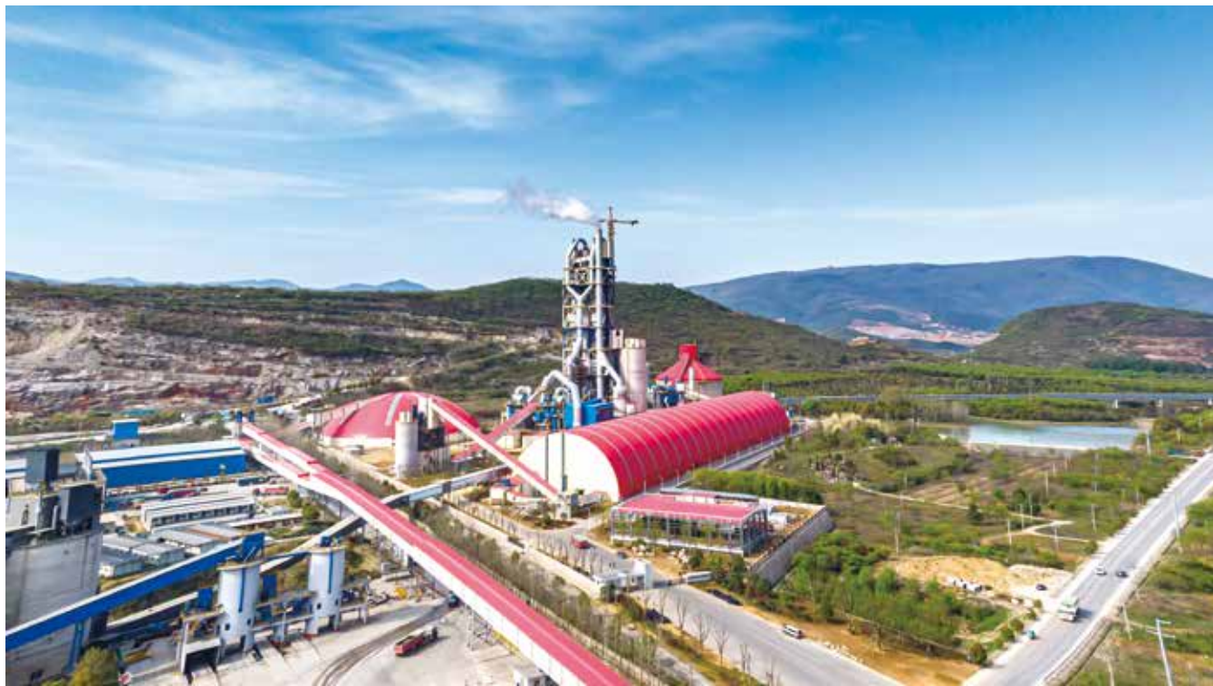
槐坎南方日产7500吨优化升级项目全景
