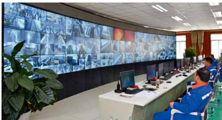
祁连山水泥生产调度系统
