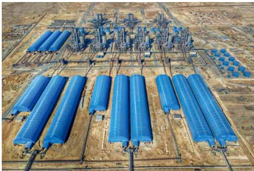
埃及GOE六条日产6000吨水泥项目
